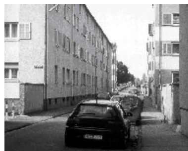
Die Tauscherstraße in Oberhausen-Nord, triste Verkehrsfläche vor der Sanierung Foto: Dürsch
