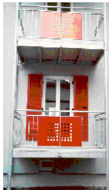
Saniertes Wohnhaus aus den 30er-Jahren Foto: Dürsch
